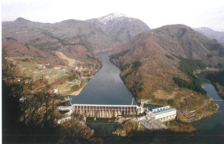
かのせ 鹿瀬発電所（鹿瀬ダム）
